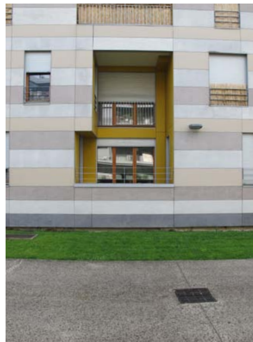
vue d'une loggia sur la façade nord du bâtiment.
