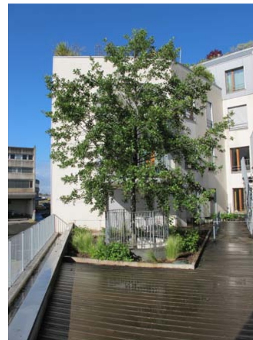
vue de la placette suspendu au sud du bâtiment.
