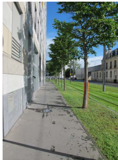
vue au pied de la façade est du bâtiment allée Eugène de la Croix.
