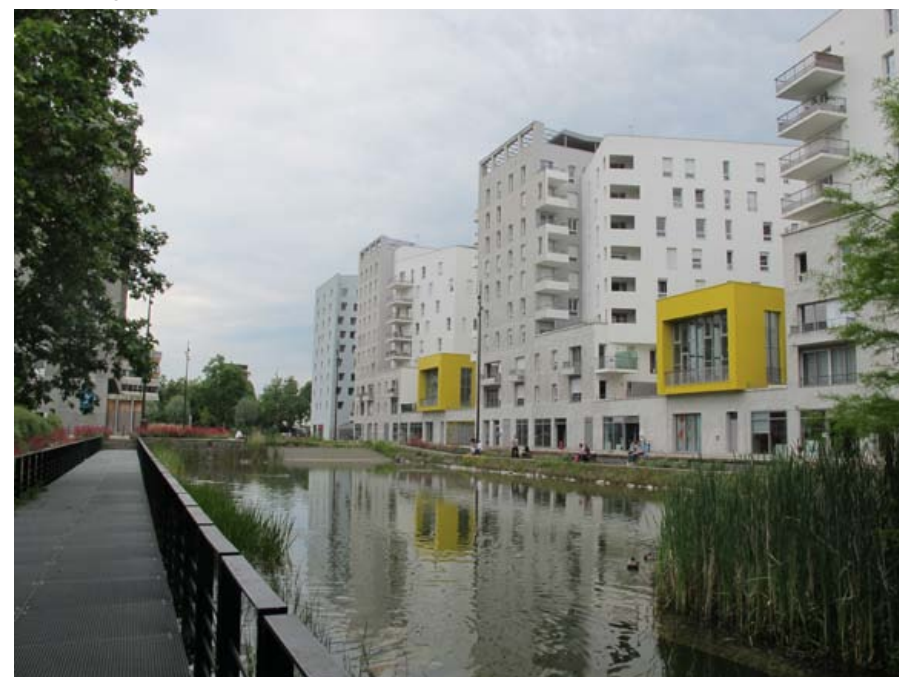
vue de la façade est, sur la promenade europa.
