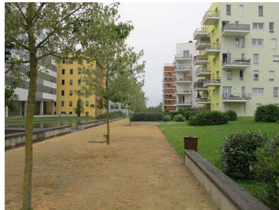
vue du jardin intérieur.
