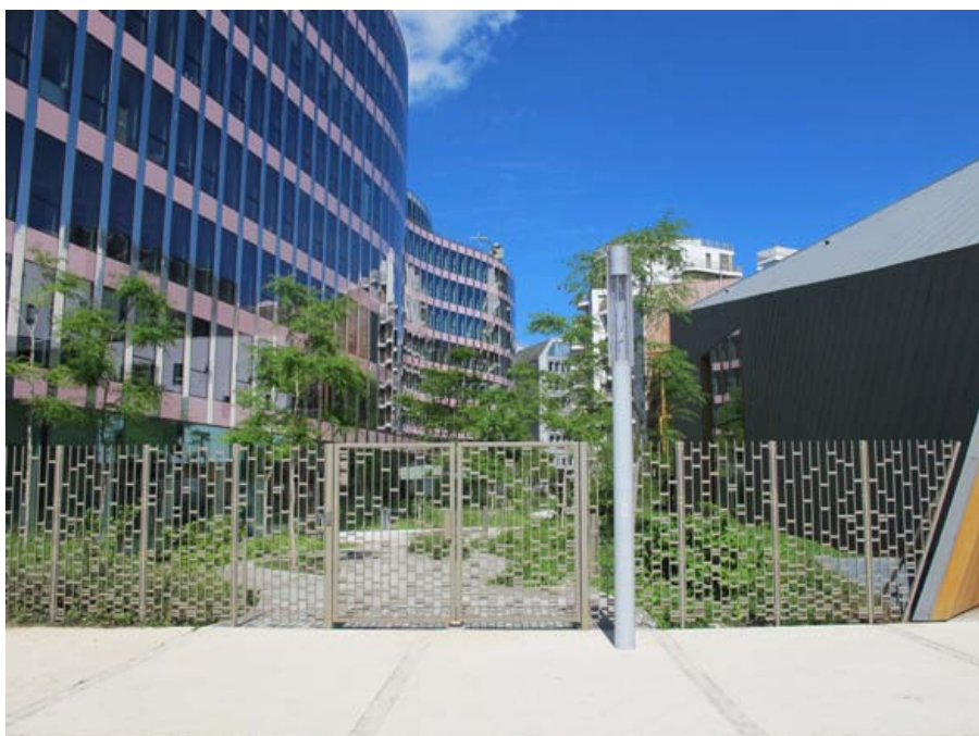
entrée est de l'îlot intérieur.
