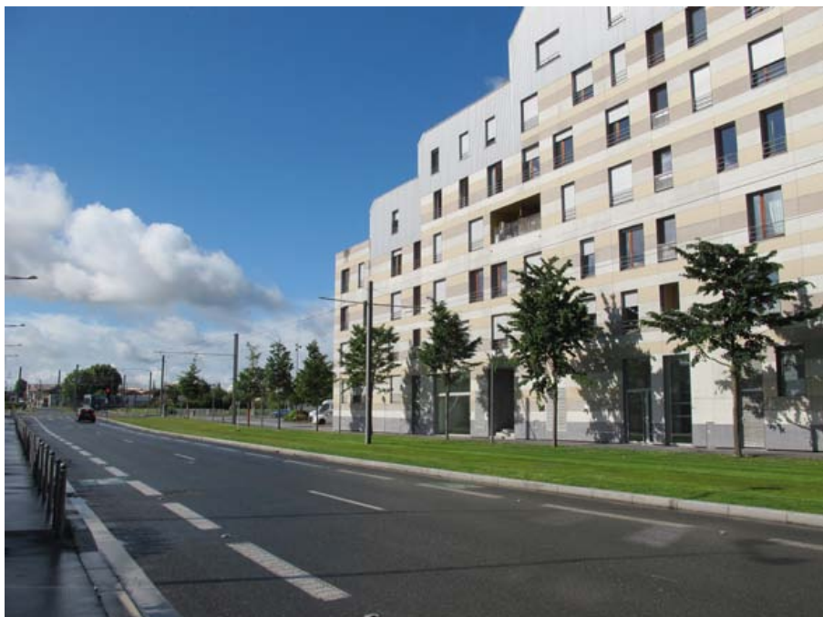
vue de la façade est du bâtiment, allée Eugène de la croix
