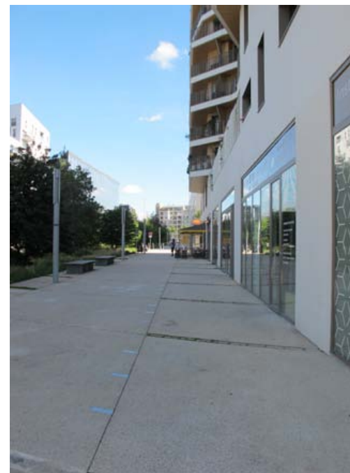
trottoir ouest, avenue Emile Zola.
