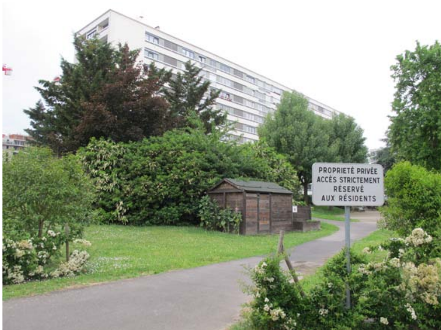
espace public du quartier à l'ouest du projet.
