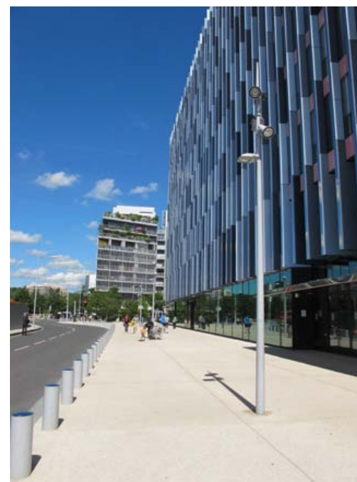
trottoir, sud, devant le bureau.
