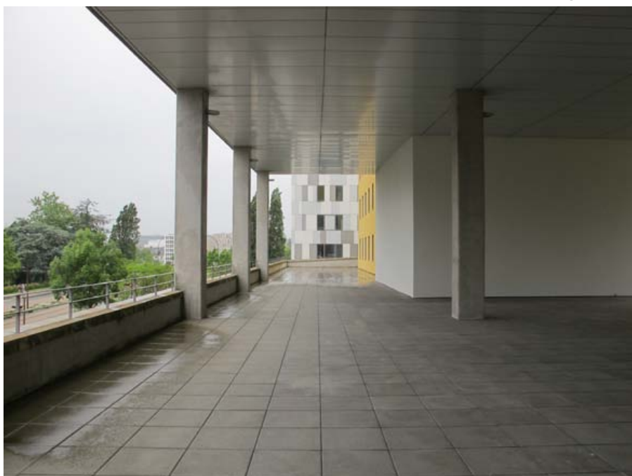
vue du dégagement sous le bâtiment des bureaux.
